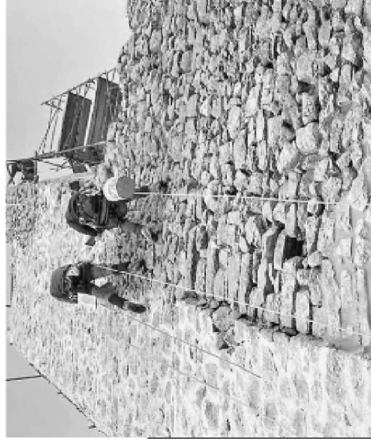
L'intervento di recupero delle torri e delle mura di Cesi, l'antico sistema difensivo a monte dell'abitato. Per rifornire il cantiere è stato necessario l'intervento degli elicotteri
